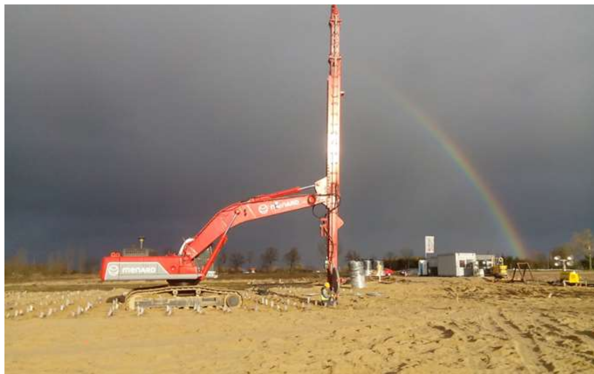
Rys. 27 oraz 28 Zdjęcia z placu budowy - wykonywanie drenów
