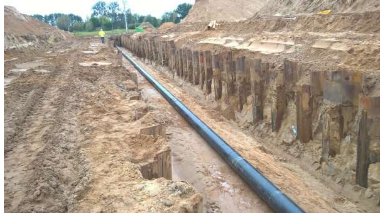
Rys. 24 Przełożenie instalacji gazowej
