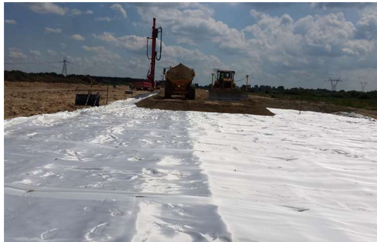
Rys. 30 Zdjęcie z placu budowy – wykonanie materaca geosyntetycznego
