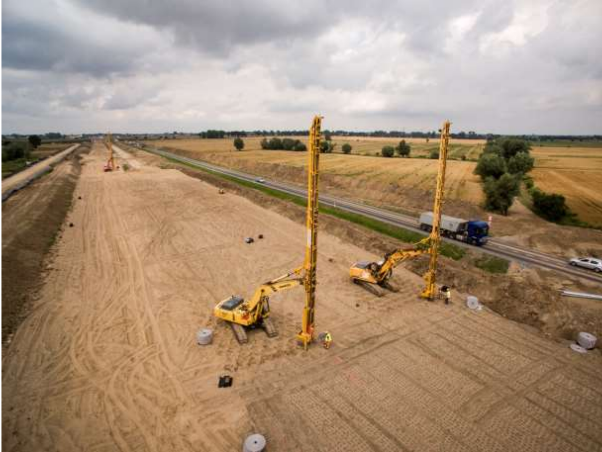
Rys. 4 Zdjęcie z placu budowy drogi ekspresowej S7- wykonywanie drenów
