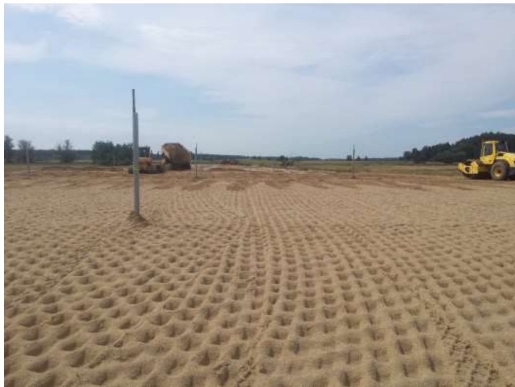
Rys. 29 Zdjęcie z placu budowy – budowanie nasypu przeciążającego
