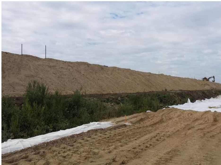
Rys. 2 Nasyp przeciążający
