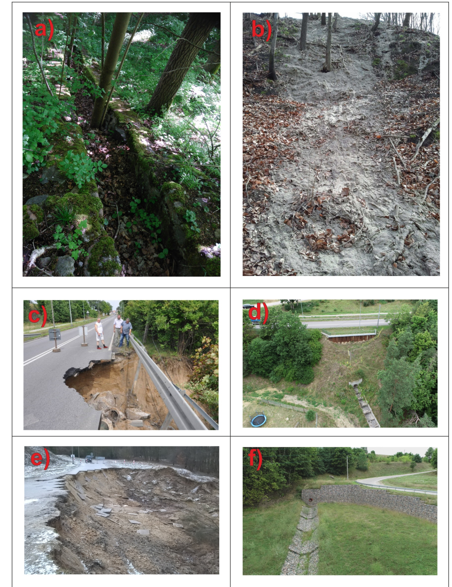
Fotografie przedstawiają wybrane ruchy masowe w Dolinie Raduni oraz sposoby ich stabilizacji za pomocą murów oporowych, drenaży i koryt w zabudowie kaskadowej (fot. Małka A., Trojanowska K., Maciaszek P., Mazur A., Cichoński B., Sreberski C.)
