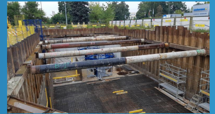
Obudowa wykopu – Equinix
