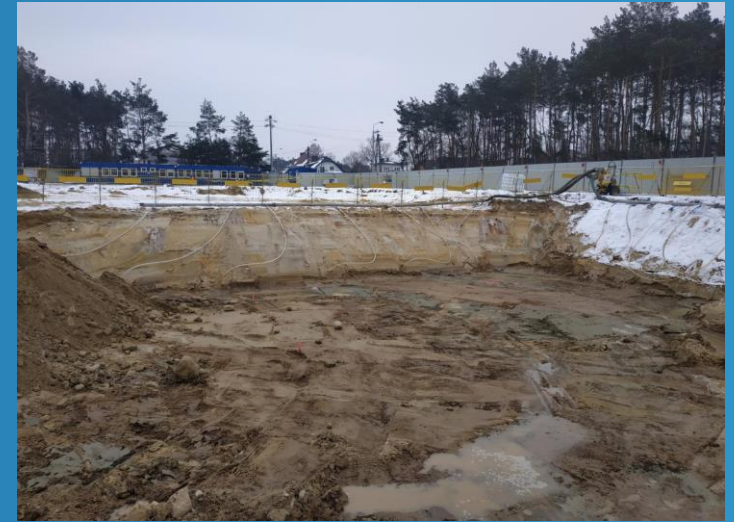
Odwodnienie wykopu – budowa Wołomin
